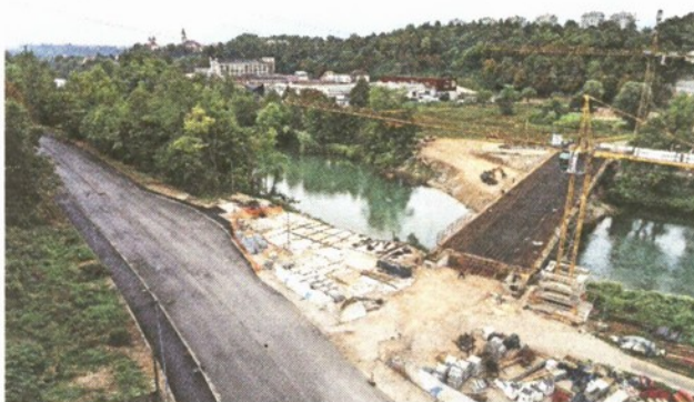
Gradnja mostu pri nekdanji Planiki in rekonstrukcija Savske ceste / Foto: Tina Dokl
